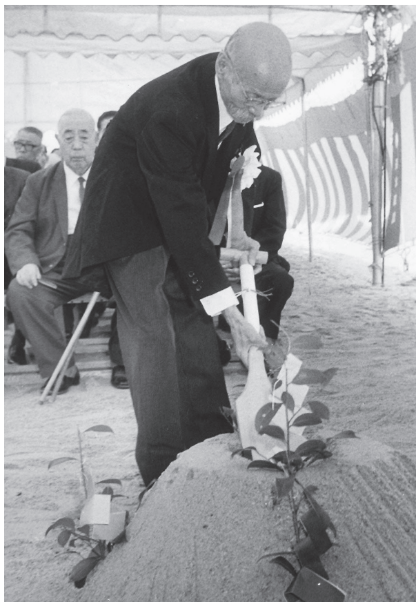
大学起工式で鋤入れを行う藪内先生
