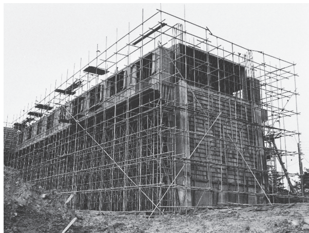
学舎の第一期工事の様子
